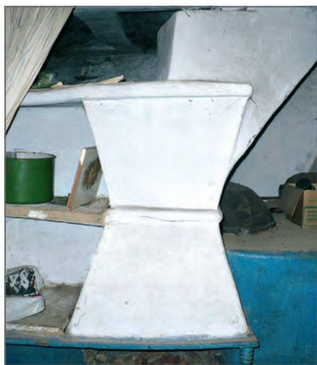
Fig. 10. Cuptor cu lejancă, or. Camenca, r-nul Camenca. Proprietară Șpac Maria. Foto: Madan Elena (2010).
